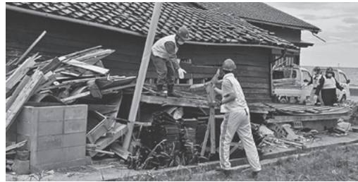
倒壊家屋からの廃材撤去作業に従事する中嶋悠太さん
